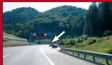
Pred predorom Podmilj, smer Maribor, elektronski portal nad avtocesto, A1 Vransko - Blagovica.
