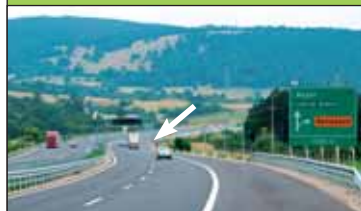
Elektronski portal nad avtocesto pred izvozom Senožeče, smer Koper, A1 Razdrto - Senožeče.
