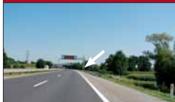
Elektronski portal nad avtocesto pred razcepom Slivnica, smer Maribor, A1 Slivnica - Fram.
