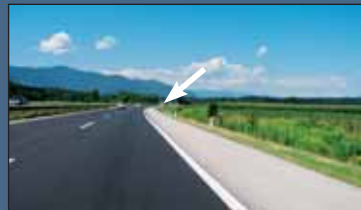
Pred viaduktom Tržiška Bistrica, smer Jesenice, A2 Kranj zahod - Podtabor.
