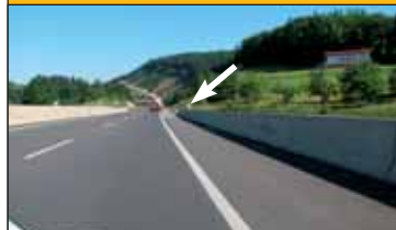
Viadukt Reber, smer Ljubljana, na koncu viadukta, A2 Malence - Šmarje Sap.
