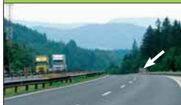
Viadukt Ravbarkomanda, smer Ljubljana, A1 Postojna - Usec.
