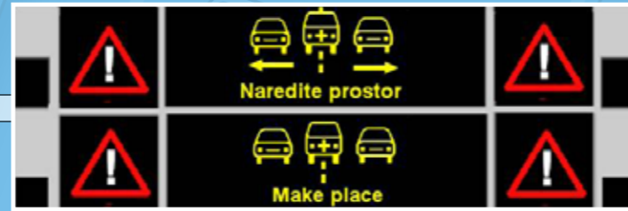
Vsebina na portalih spremenljive prometno informativne signalizacije Content on variable traffic information portals
